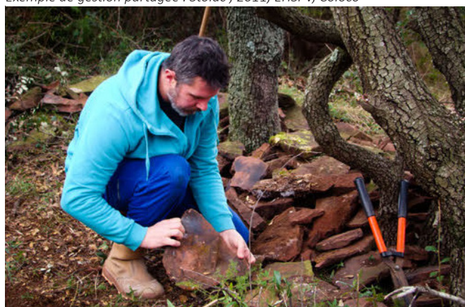
Exemple de gestion partagée : construction d'un escalier en pierre, cœur d'Hérault, 2014 (Coloco)
